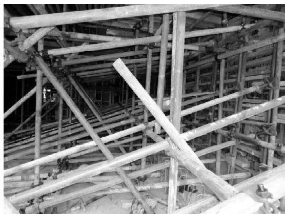
图7 单侧支模加固图
