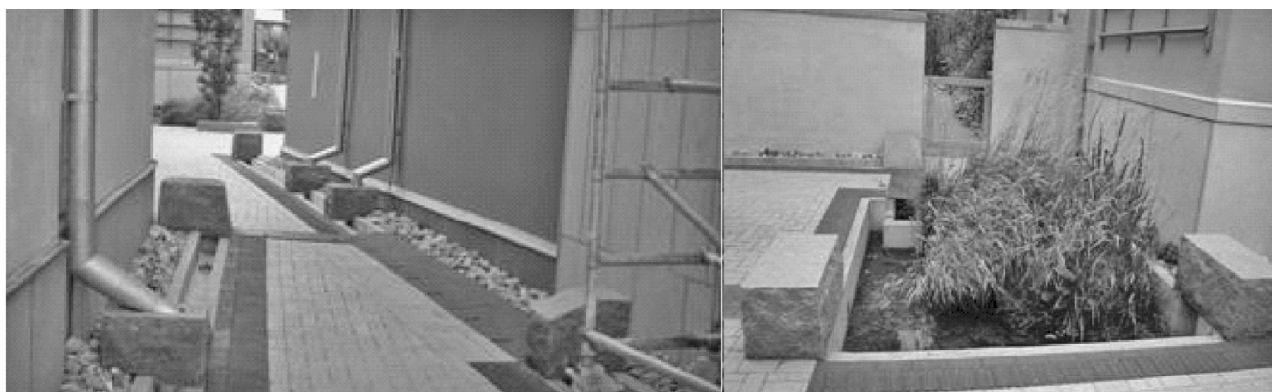
图3 屋面雨水收集利用示例
